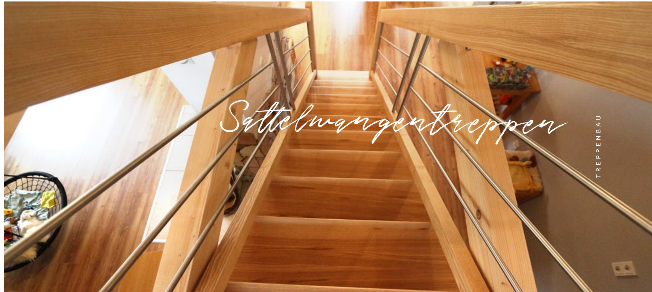
Sattelwangentreppe mit Edelstahlgeländer
