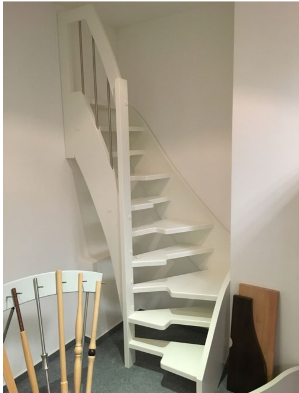
Treppe mit Wechseltritt in weiß RAL 9010 geringer Platzbedarf Stufen- und Wangendicke 40 mm
