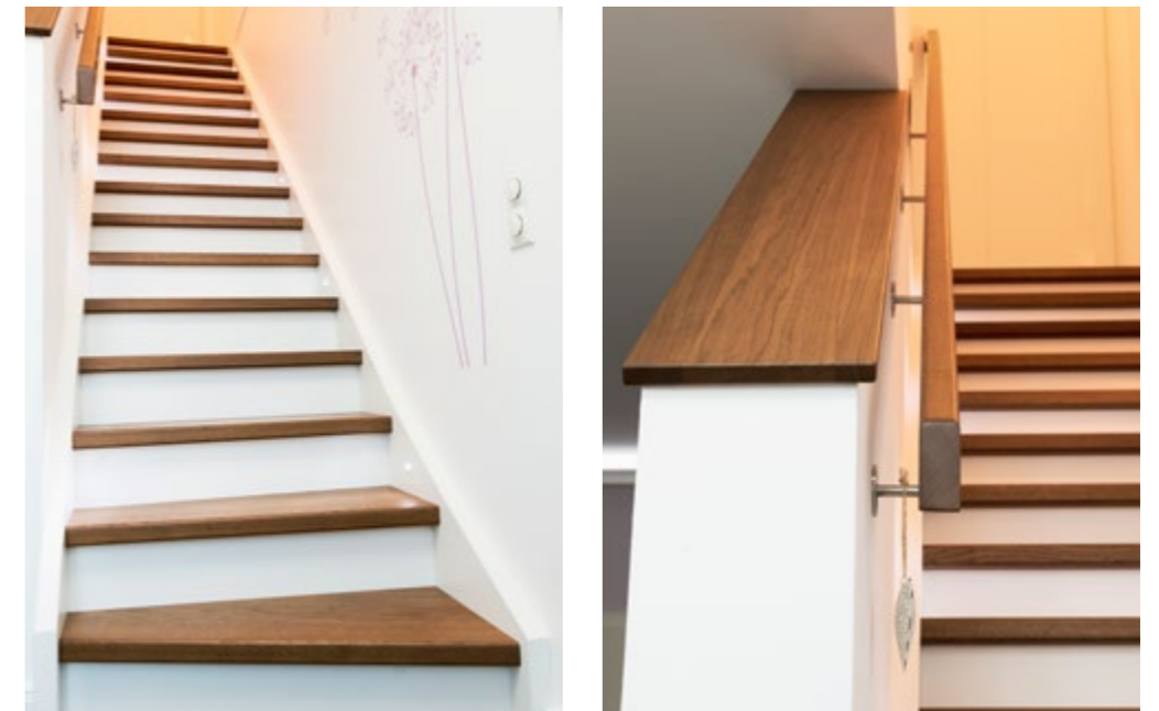
Holzart: Esche, dunkel geölt zwischen zwei Wänden mit Setzstufen Ablage aus Esche auf Mauerwand
