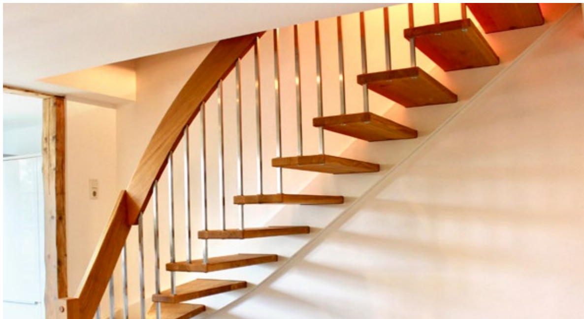
Holzart: Eiche Natur Wange wandseitig, innen freitragend Edelstahlstäbe und Distanzen aus Edelstahl eckig
