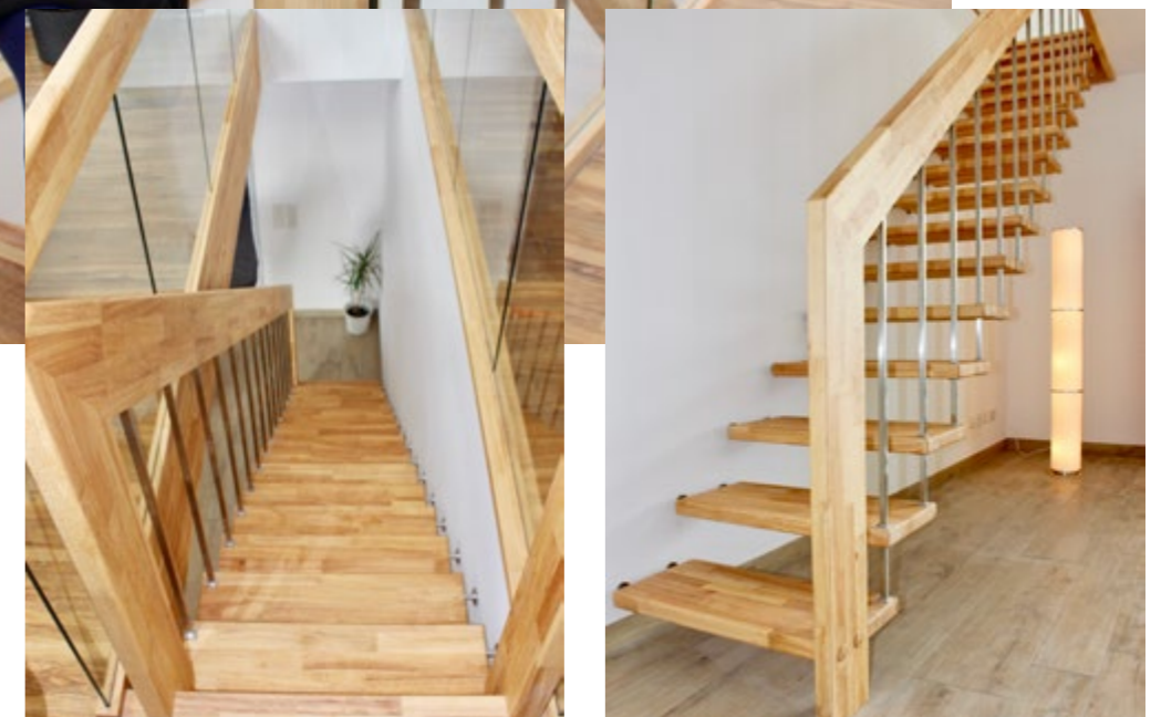
Holzart: Hevea Mosaik Glasbrüstung in Bodenleiste und Deckenstirn Edelstahlstäbe eckig
