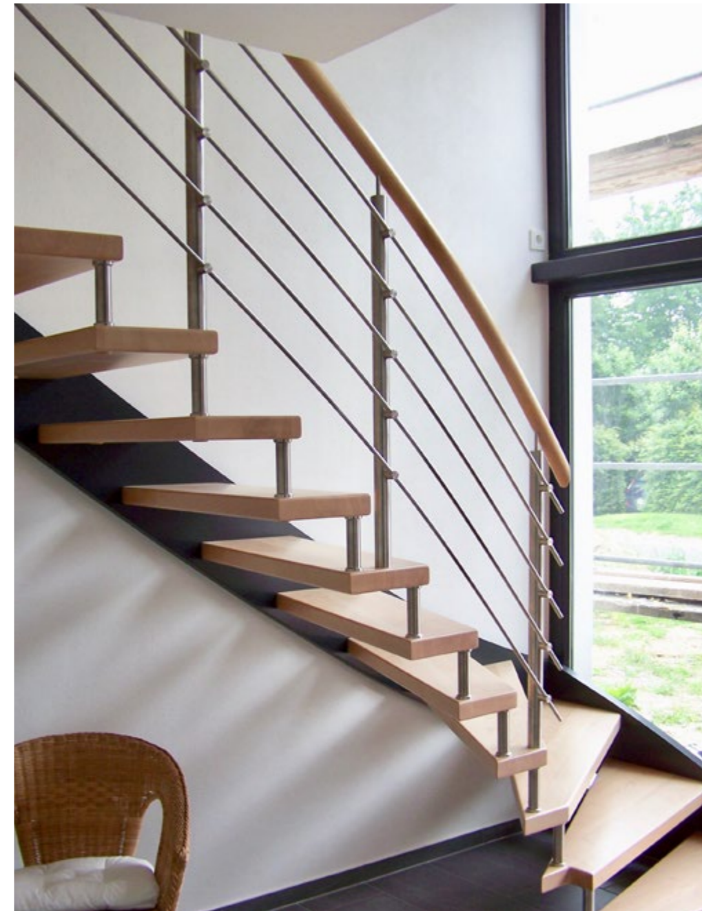
Holzart: Ahorn, Oberfläche lackiert Treppe mit dunkel lackierten Wangen gebogene Edelstahlgurte, runder Handlauf
