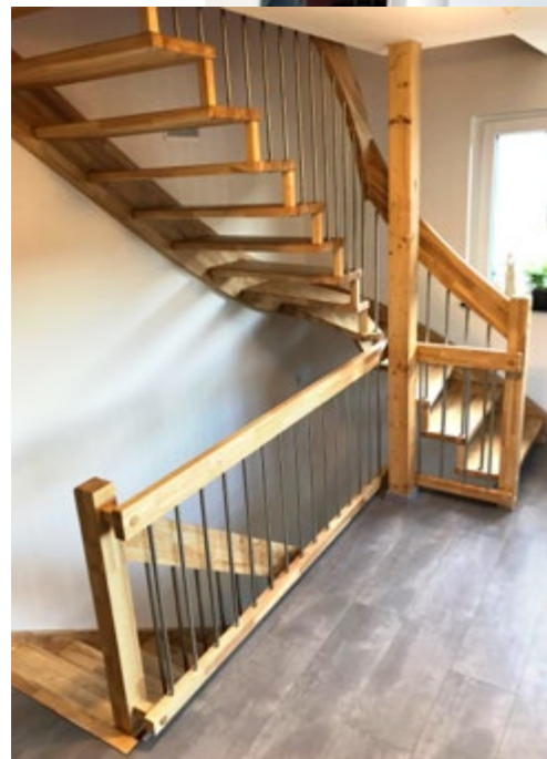
Holzart: Hevea Mosaik freitragend mit Edelstahlstäben eckig und schlichtem Pfosten
