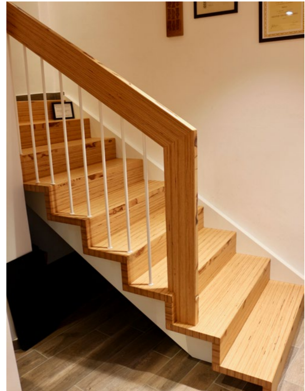
Stufen in Falterwerkoptik Sattelwange zurückgesetzt in weiß Wandseitig gestemmt Handlauftragend mit Füllstäben weiß lackiert
