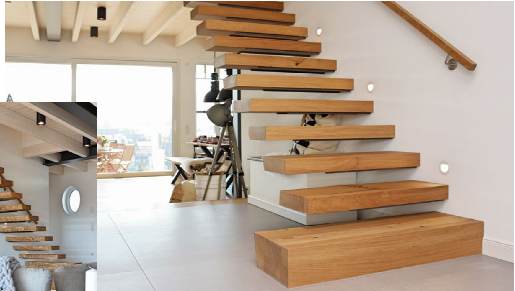
Holzart: Eiche mit Baumkante in massiver Optik Blockstufe am Antritt Wandhandlauf mit Wandhaltern
