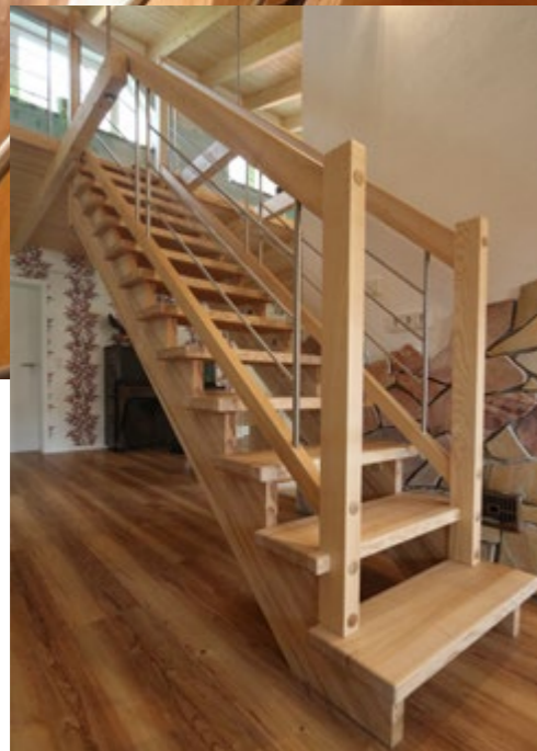
Holzart: Esche mit Kern mitlaufende Edelstahlgurte 12 mm, rund Brüstung mit Bodenleiste Oberflächen geölt
