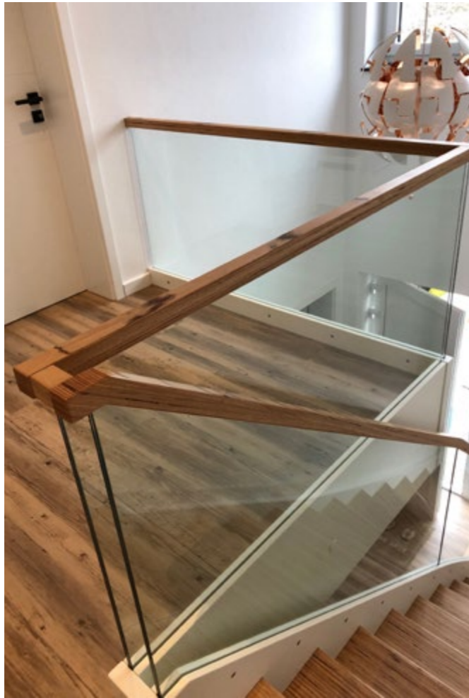
Holzart: Designbuche Deckenstirnblende Weiß RAL 9010 gespannte Konstruktion mit 17er Glasscheiben
