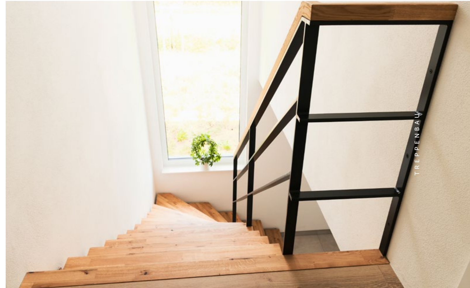
Holzart: Eiche Mosaik, geölte Oberfläche Flachstahl basaltgrau lackiert und Wandbolzen
