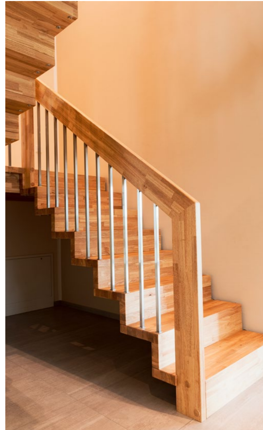
Holzart: Hevea Mosaik Flachposten und Holzgeländer mit Edelstahlstäben eckig passende Glasbrüstung
