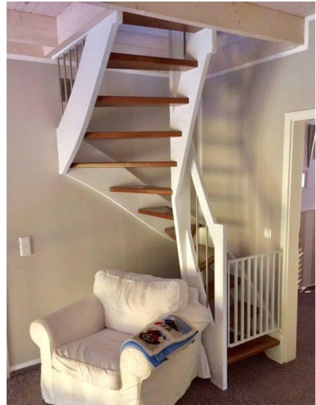
Holzart: Eiche Mosaik Wangentreppe 1/2 Dreieck unter Decke geschlossen mit Edelstahlstäben 16 mm rund Flachpfosten 90 x 40 mm
