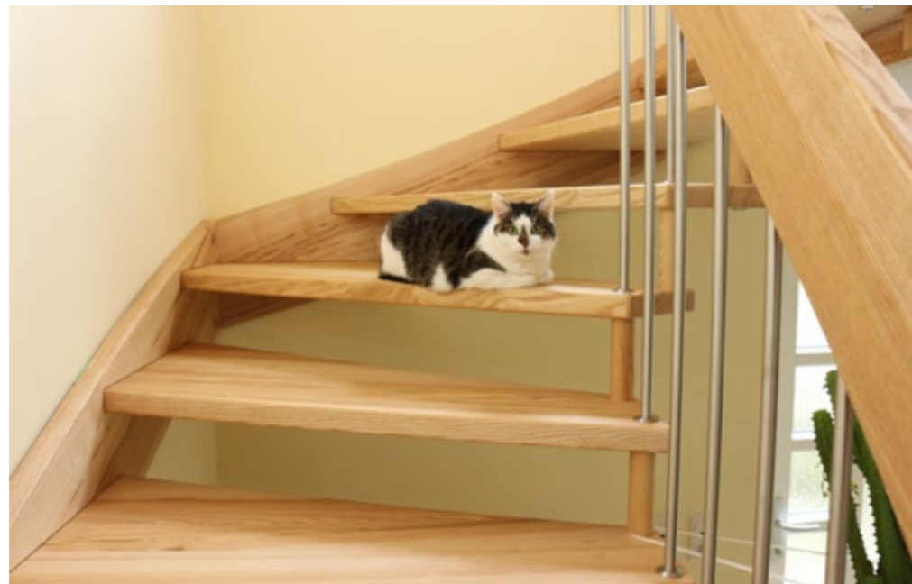
Holzart: Esche mit Kern Wandwange und Edelstahlstäbe rund Deckenstirnblende und Brüstungsgeländer
