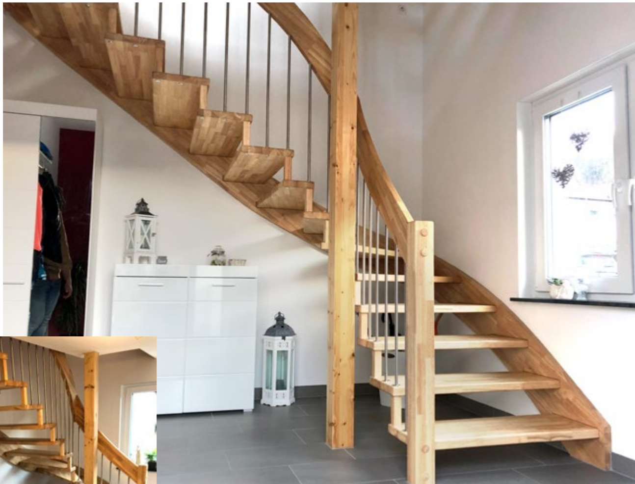
Holzart: Hevea Mosaik freitragend mit Edelstahlstäben eckig und schlichtem Pfosten
