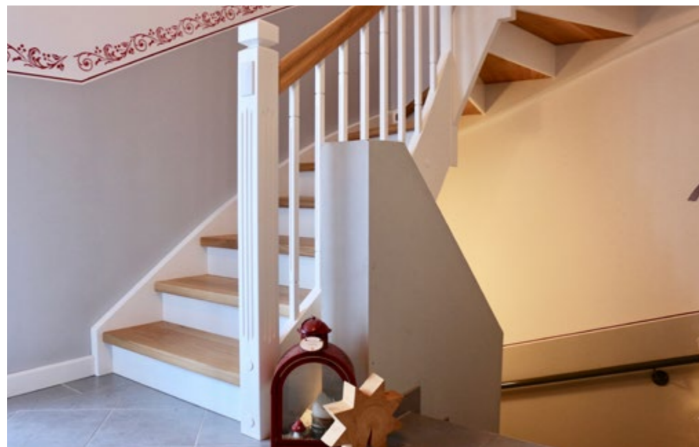
Holzart: Eiche durchg. Lamelle Landhausstil mit profilierten Stäben, Kanelüren in Pfosten und Omega Handlauf
