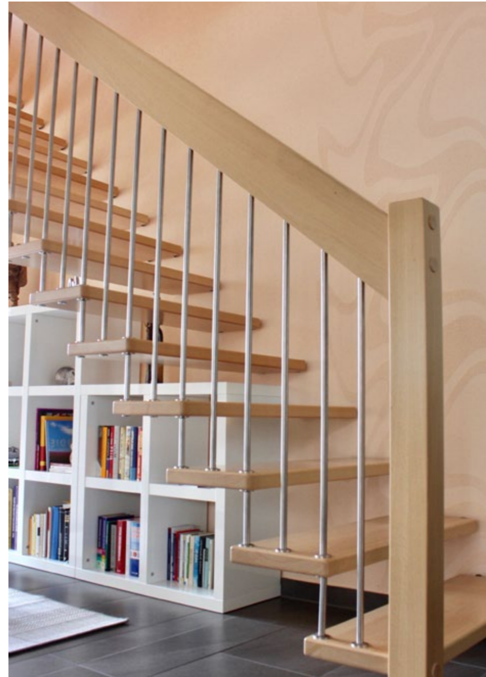
Holzart: Buche Lamelle Edelstahlstäbe und Distanzen aus Edelstahl rund Brüstungsgeländer mit Zwischenpfosten
